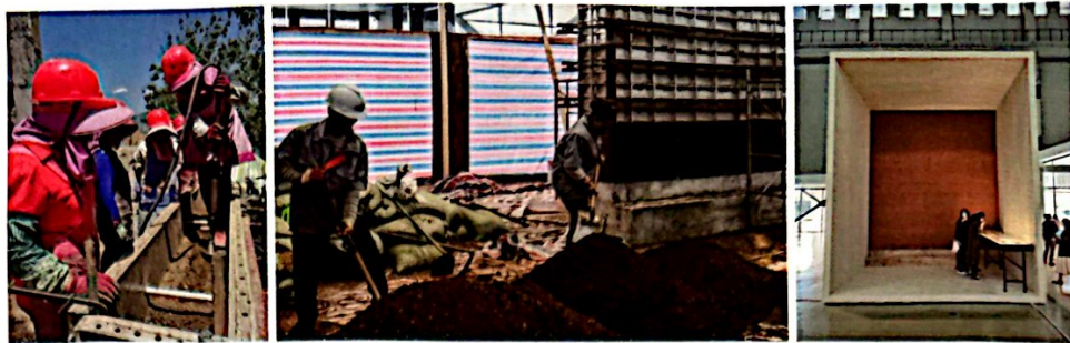
8 妇女施工队正在进行施工培训 9 妇女施工队的工匠们在上海当代艺术博物馆进行夯土墙施工 10 第 13 届上海双年展参展装置——水系避难所 #2
